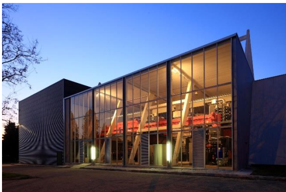
Chaufferie bois de la Motte Rouge
