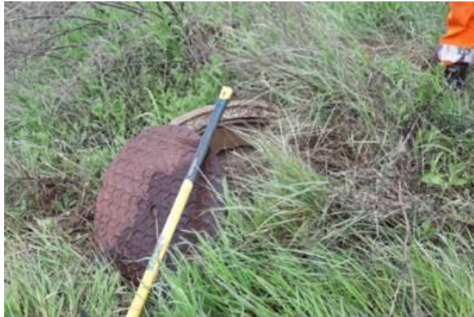
Figure 2 : Possibilité d'infiltration des ECPM dans le réseau d'assainissement (Courmonterral)
