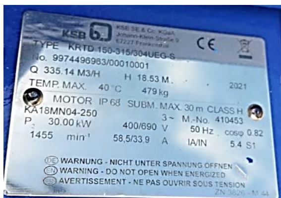
Renouvellement de la pompe de relevage M0205 Janvier 2021
