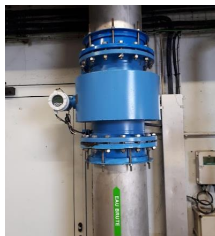
Renouvellement du débitmètre entrée de la STEP de Gour de Lamy Décembre 2021
