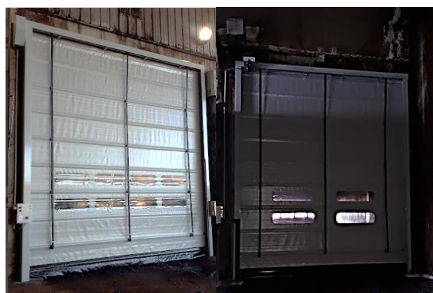
Renouvellement des portes rapides du tunnel de la compostière Février 2022
