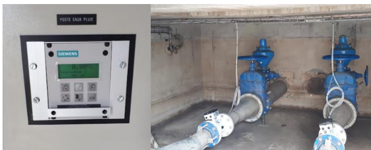
Renouvellement des débitmètres refoulement et trop plein du PR Saussan août 2021.
