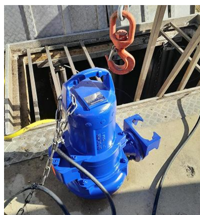
Renouvellement de la pompe de relevage 2 de la STEP de Villeneuve les Maguelone Février 2022
