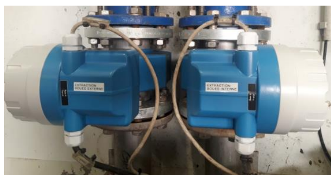
Renouvellement des débitmètres d'extraction. Décembre 2021
