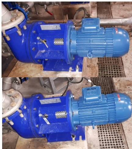
Renouvellement des pompes à sables M03 09 et M03 10 Janvier 2021
