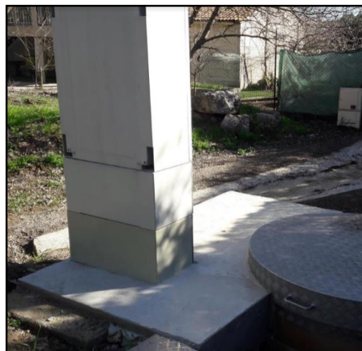
Site après travaux
