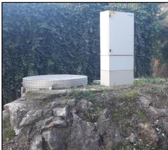
Site avant travaux
